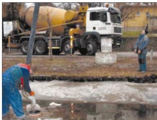
Ezután vált lehetővé a csövek betonnal való feltöltése, amit a KEVEBETON – Bozóki István végzett el.
