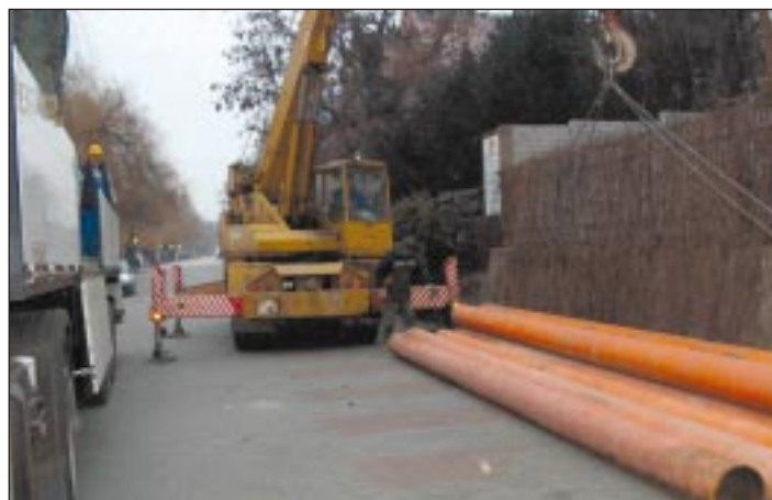
Hétfőn délután a HAVÁRIA Kft. – LARSENEN DEPO Kft. szállította a nagy átmérőjű, 11 m hosszú csöveket.
