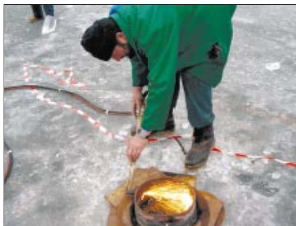
Csütörtökön Kirchner Ferenc – Technikai Brigád Bt. – azonos magasságúra vágta a jég felett lévő csövek végét.
