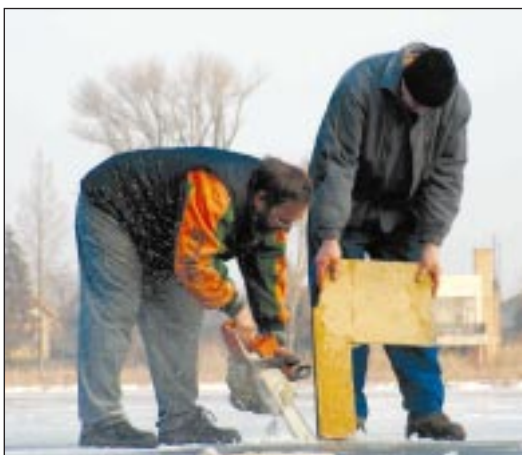
Több mint 20 cm vastag volt a jég, biztonságosan lehetett rajta dolgozni. Mint egy rajzszalagon, a jégen kirajzoltuk a cölöpök helyét, amit ezután a STIHL szaküzlet tulajdonosa, Taligás Sándor vágott ki 2009. 01. 10-én szombaton.
